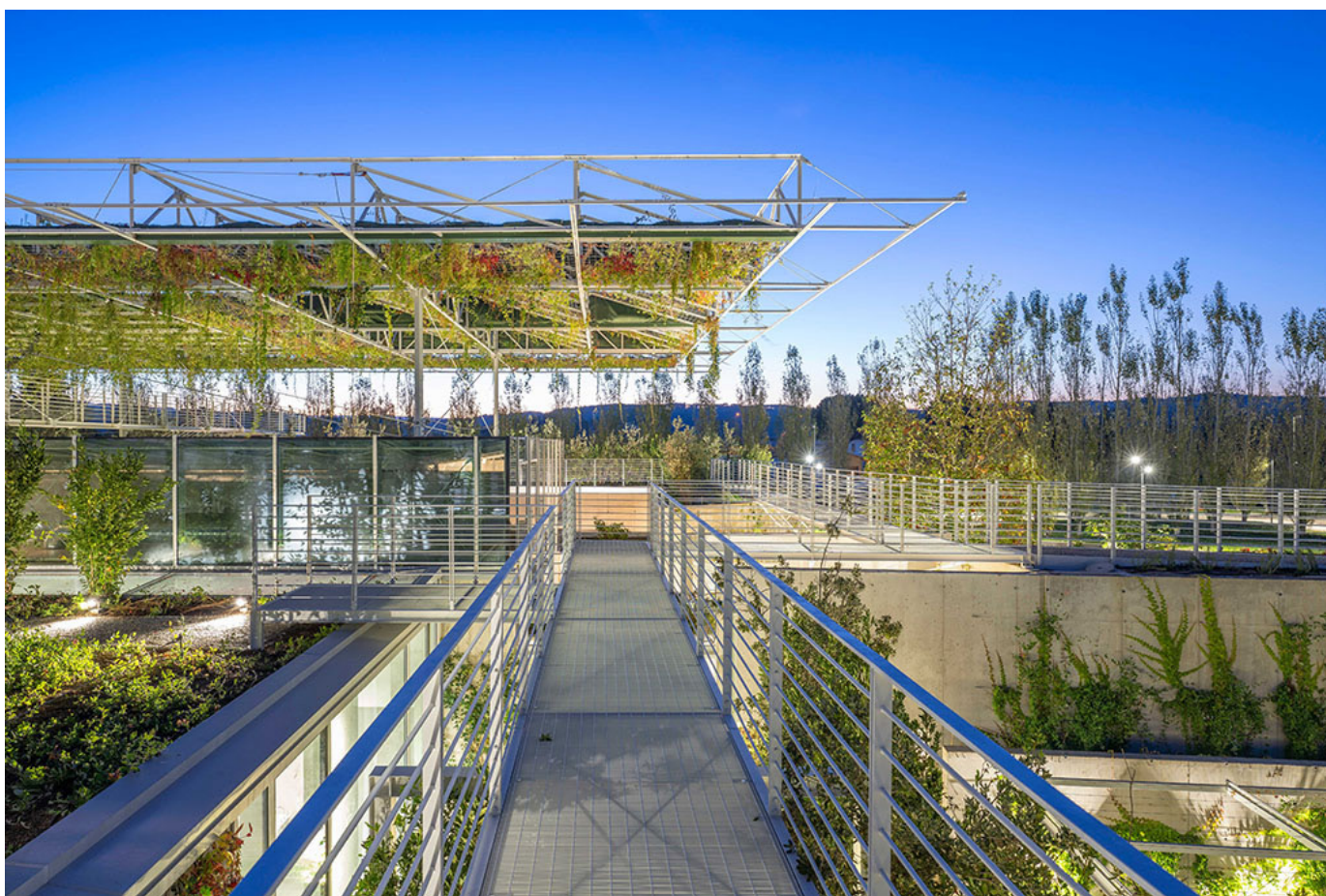
STABILIMENTO PRADA LEVANELLA MODULI PER INVERDIMENTO COPERTURA LEGGERA PH. CREDIT GABRIELE CROPPI
